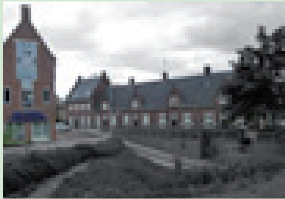
De gebouwen markeren de entree naar de Langekerstraat. Fysiek is de historische verbinding verdwenen, visueel niet. De schaal van het nieuwe winkel- en appartementencomplex (links) is groter in vergelijking met de omliggende bebouwing.
