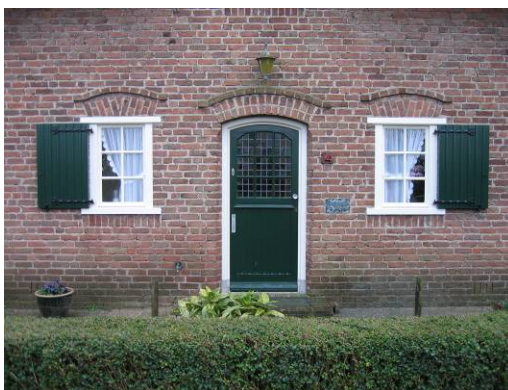
Opmerkelijke in 1948 uit kloostermoppen opgetrokken volledig gaaf bewaarde enigszins archaïsch aandoende T-boerderij Spanbroek aan de Zandheuvel bij Haalderen (architect H.W. Valk).
