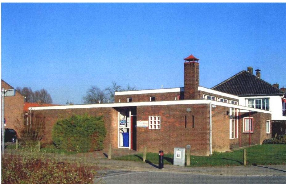
Kruisgebouw van het Wit-Gele Kruis in Sluisbil (bron: Merwijk. T. van, Kruisgebouwen).
