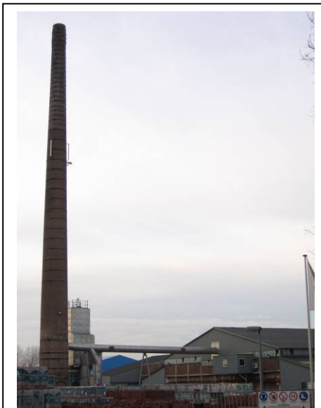
Schoorsteen steenfabriek Wienerberger aan de Buitenpolder bij Haalderen.
