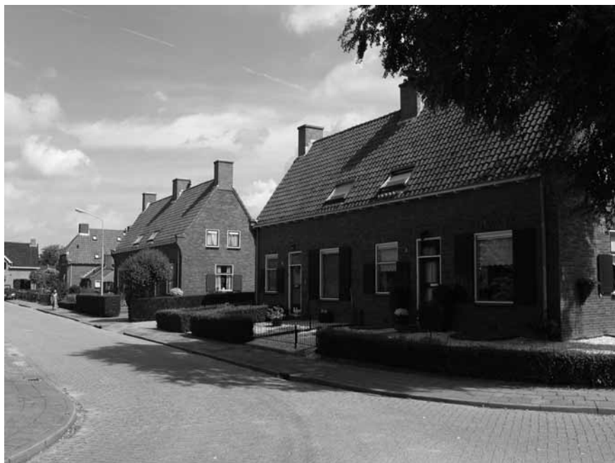
Wederopbouwoningen zoals aan de Zekweg in Dodewaard vormen een tastbare herinnering aan het herstel van de oorlogsschade. (Foto: G. Derks, Arnhem)
