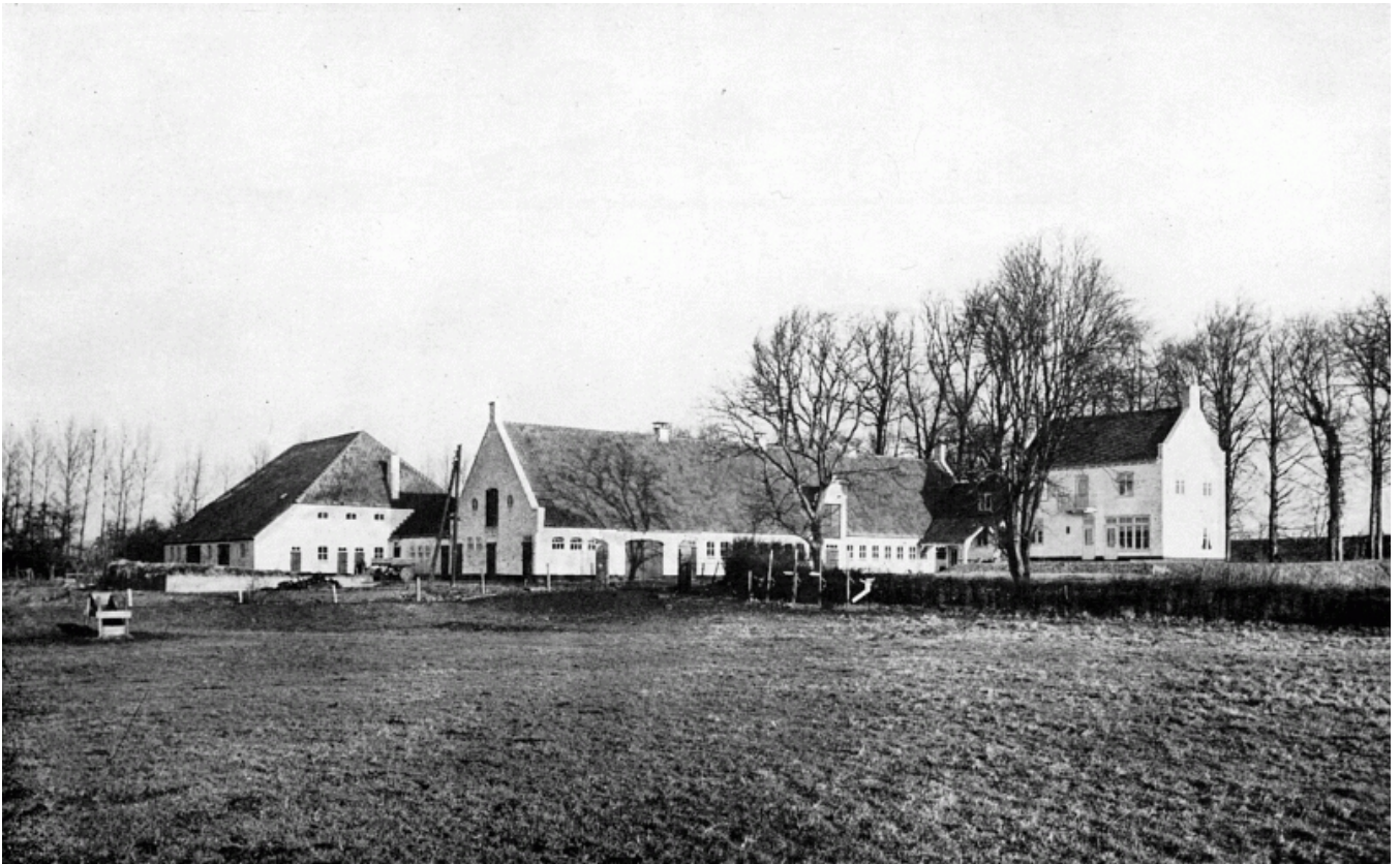
Het op een oude bouwplaats gelegen in 1949 herbouwde boerderijcomplex Doornik 1 (gemeentelijk monument) bij Bommel, een ontwerp van de bekende Arnhemse architect G. Feenstra in samenwerking met Th.N. Dinnessen (uit: Bouwkundig Weekblad, 68 (1950)14/15, p.239).
